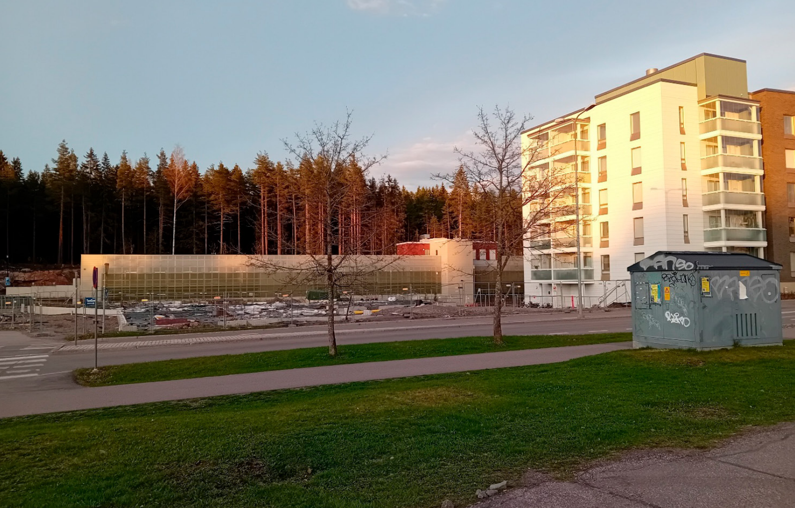
Aloitettu keskeneräinen rakennustyö Alhotiellä. Kuva: Seppo Heino
